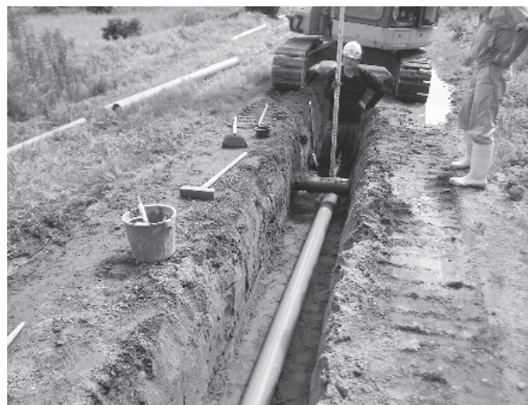
急がれるインフラ復旧（下水道工事）
