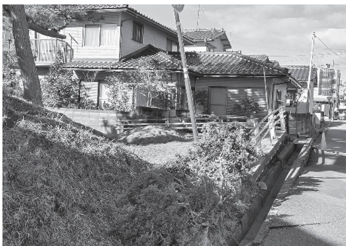
液状化で隆起した防火水槽（大根布）
