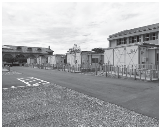
向栗崎の仮設住宅
