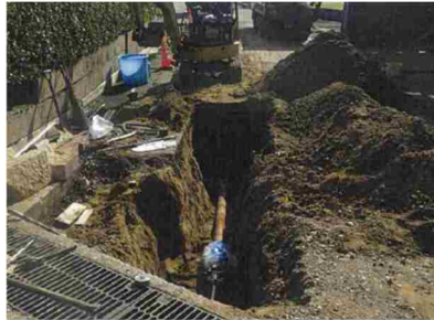
水道管の復旧作業
