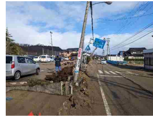
写真④ (西荒屋付近)
