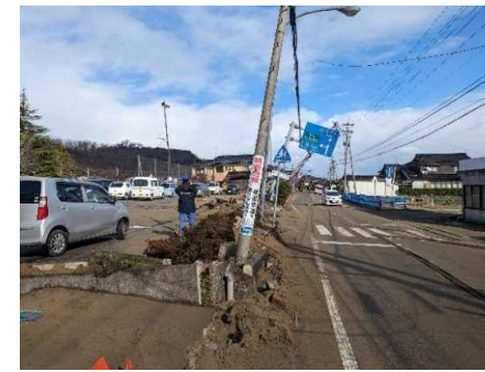
写真④（西荒屋付近）
