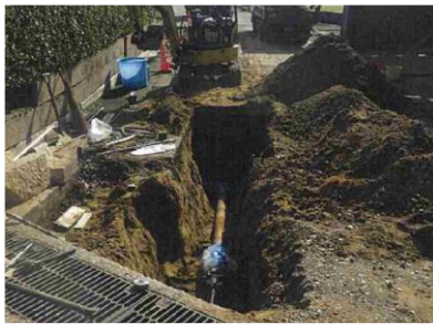
水道管の復旧作業
