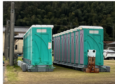
仮設トイレの設置状況
