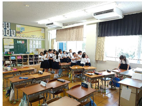
【小学校に空調設備を整備】
