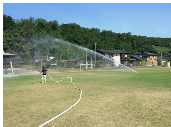
【西荒屋小学校散水設備】
